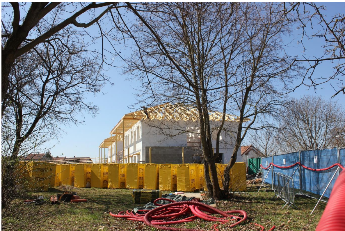
Foto: výstavba nových domků
