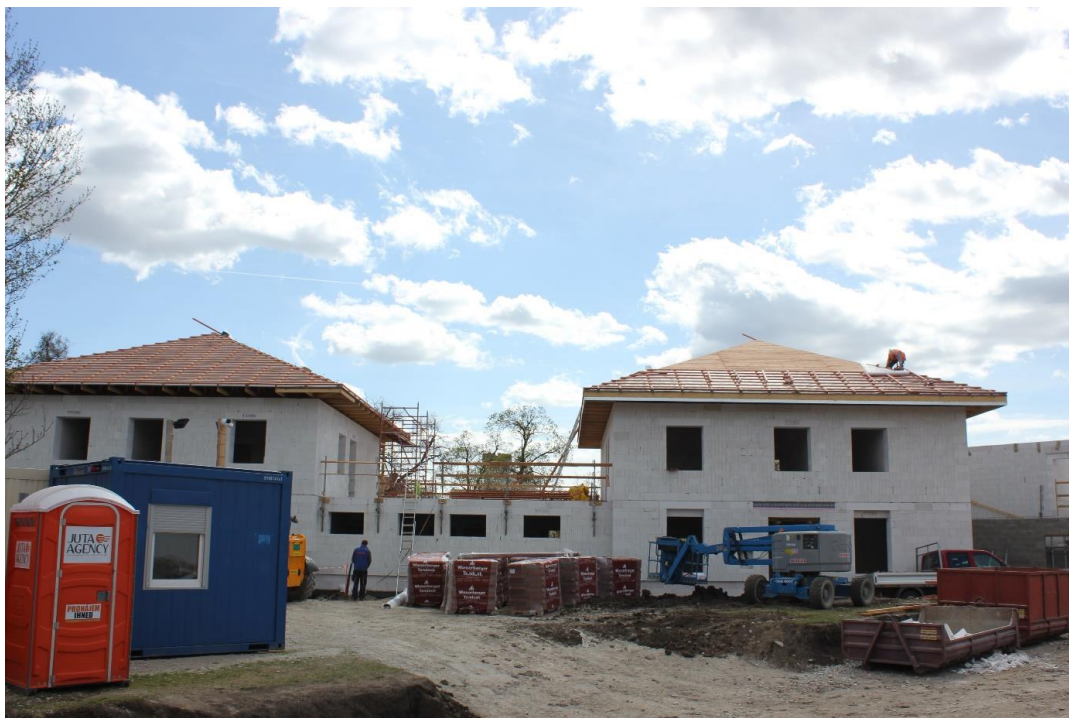
Foto: výstavba nových domků
