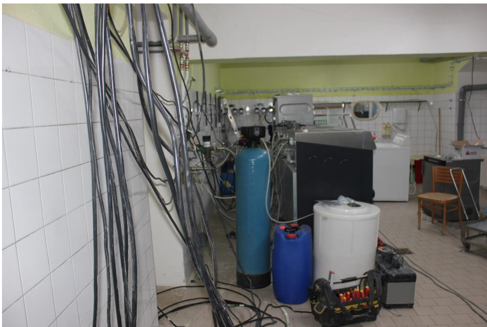
Foto: rekonstrukce prádelny
