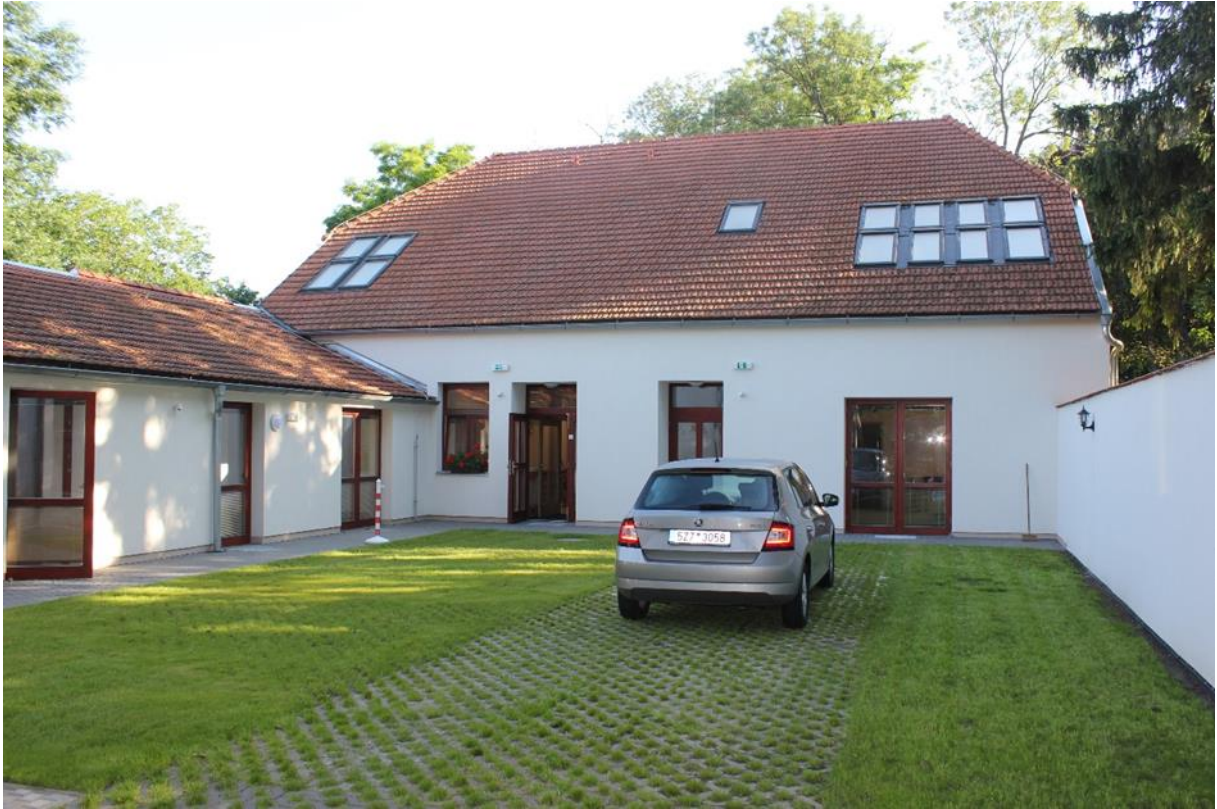
Exteriér zrekonštruovaného objektu Hájenka-stodola
