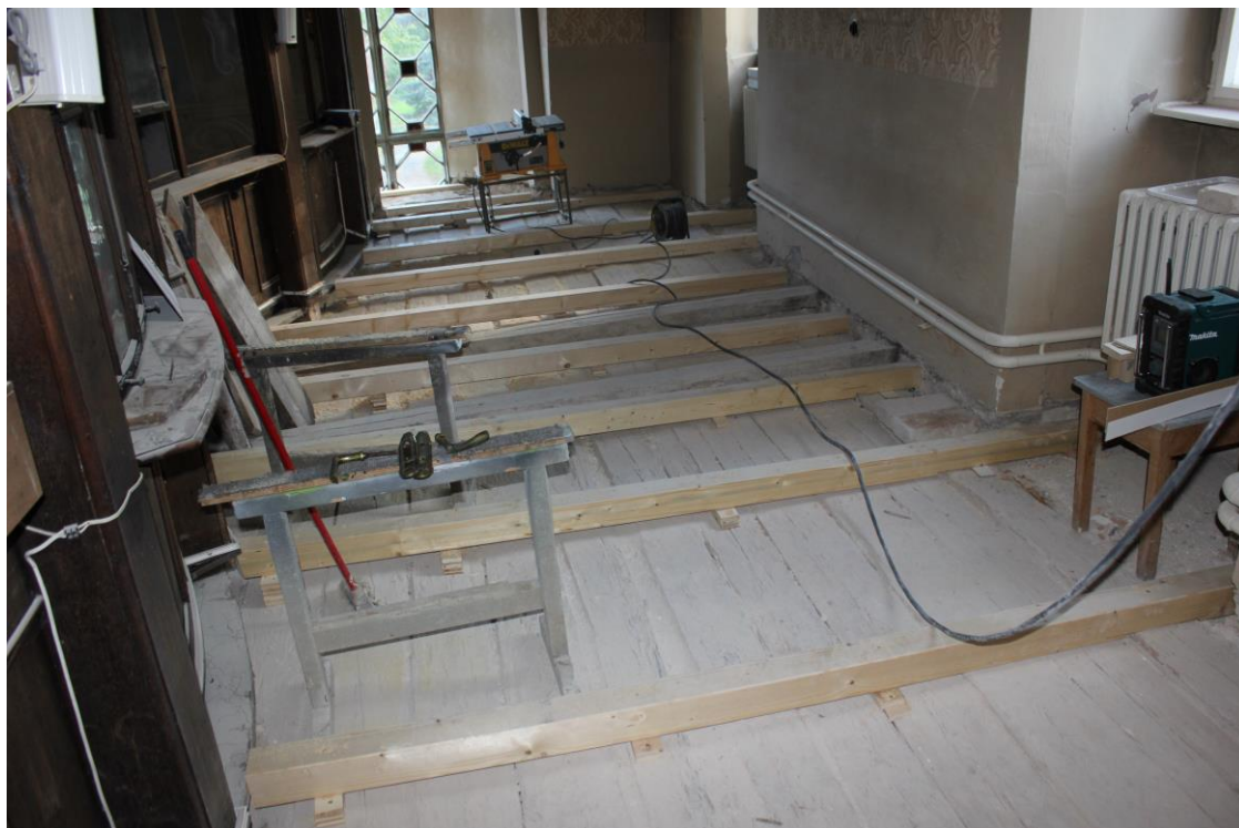
Podkladní vrstva před položením finálních kazet podlahy.
