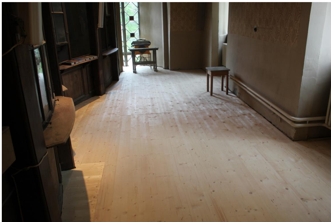
Finální povrch podlahy kůru před povrchovou úpravou.
