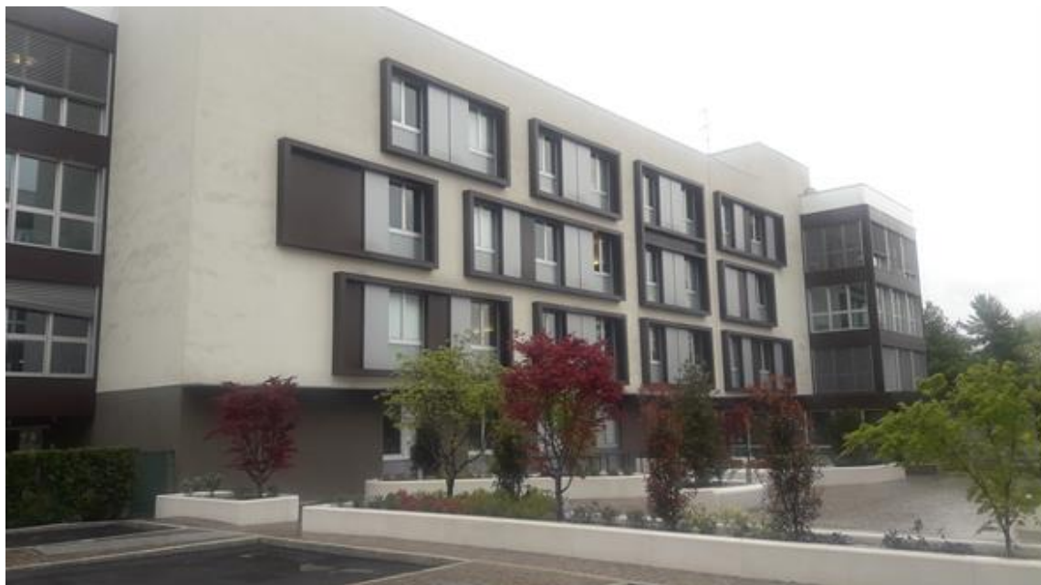
Pohled z parku na ubytovací pavilony.
